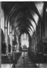
Abb. 390. Innenansicht des Domes von Augsburg (Mitte des 14. Jahrh.) (Phot. Stödtner).
